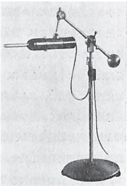
第二十七図。腔照射用石英燈
