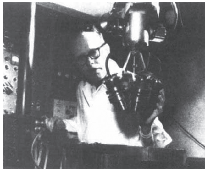
図17. Dr. William Fry と、彼が製作した動物やヒトの中枢神経系に点状病変を作製する一連のトランスデューサ。一点に向けて4つのトランスデューサを使用している (University of Illinois Press, Urbana, IL の許可を得て転載)..
